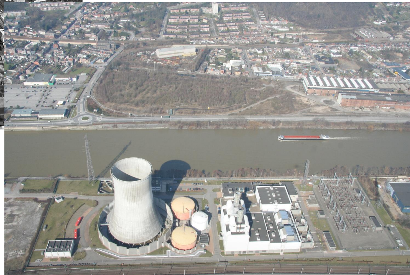
Cokerie Flémalle (Belgium) - 2006
